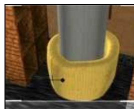
fasciatura tubazioni in corrispondenza dei solai
